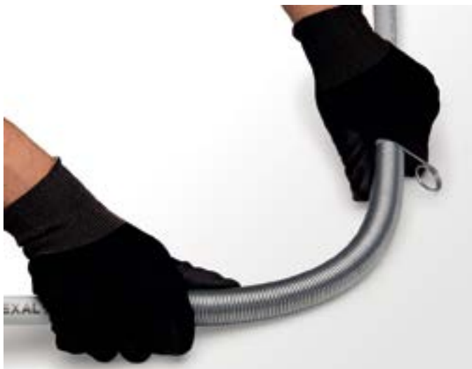
Pliage manuel avec ressort
